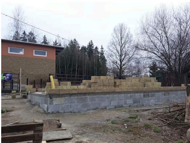
Počátky stavby pavilonu "Bongo"
